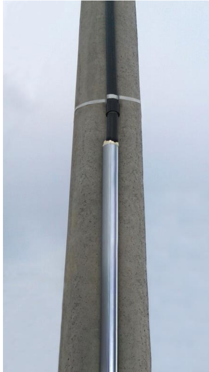
Foto ilustrativa 01 dos anexos D, E, H e I – Detalhe do eletroduto junto ao poste
