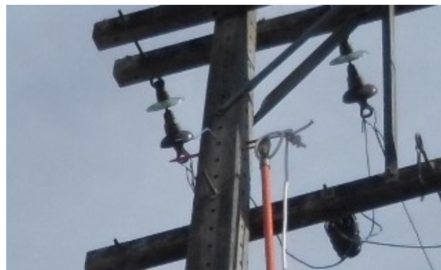
Figura 31 – Instalação do agulhão no poste
