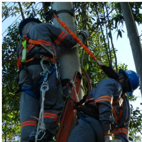
Figura 47 – Socorrista passando o talabarte de posicionamento
