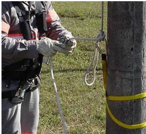
Figura 39 – Instalação do trava-quedas
