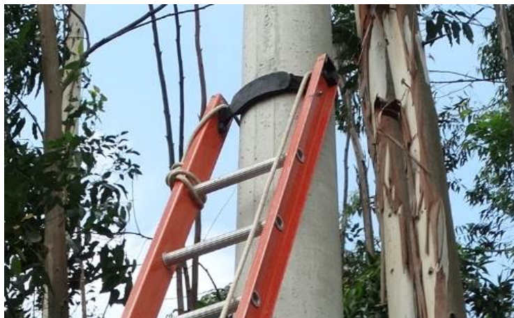
Figura 22 – Posicionamento da escada
