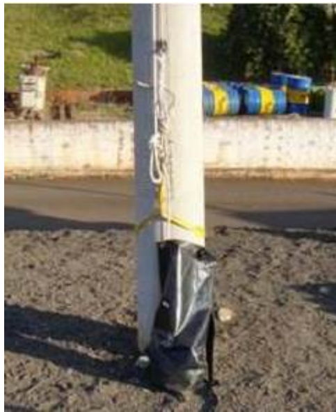
Figura 32 – Instalação do trava-quedas na parte da linha de vida do nó oito duplo
