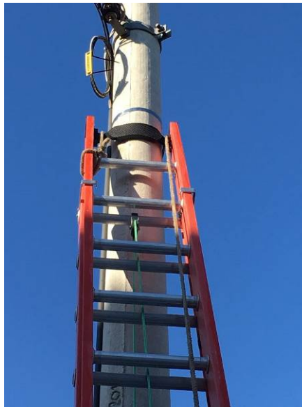
Figura 23 – Posicionamento da escada
