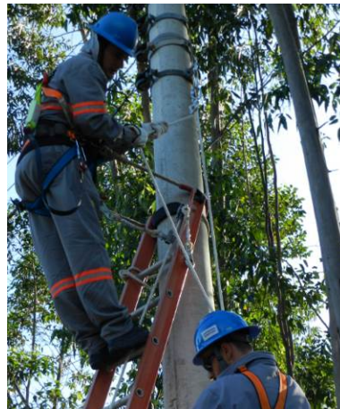
Figura 51 – Descer a vítima até o solo
