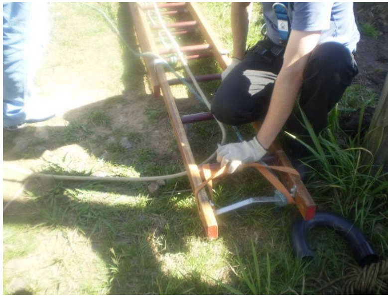
Figura 13 – Instalação da linha de vida
