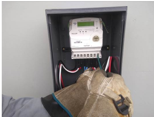
Figura 3 – Retirada do condutor de saída
